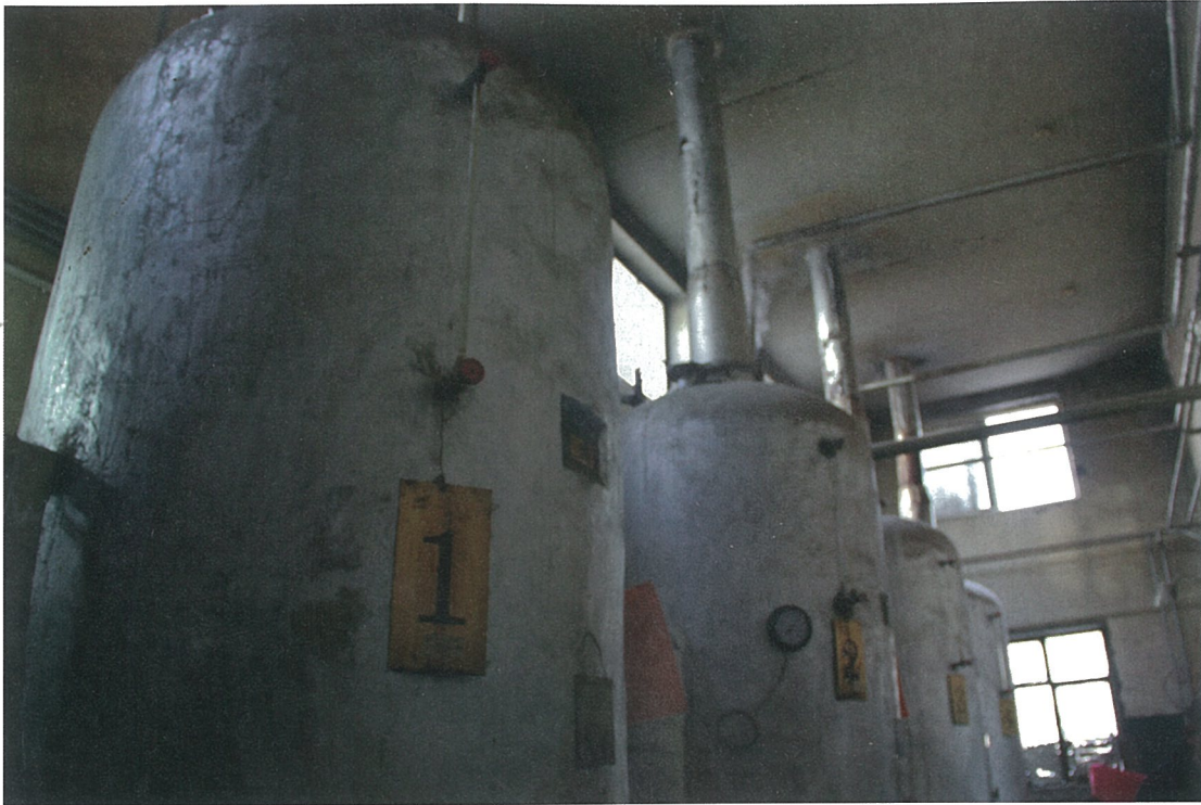
▼ 北师大锅炉房
